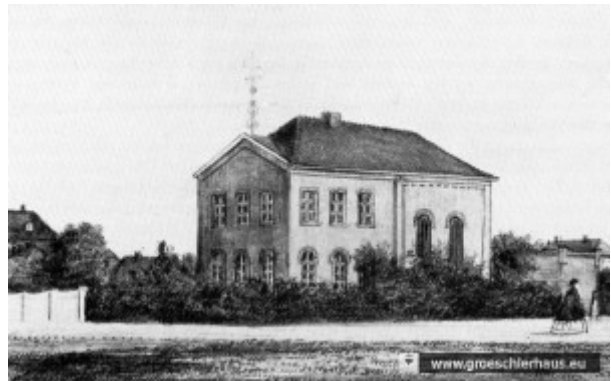
Die 1848 im klassizistischen Stil erbaute Synagoge von Varel. Synagoge, Schule und Lehrerwohnung befinden sich unter einem Dach. (Zeichnung von 1860)
