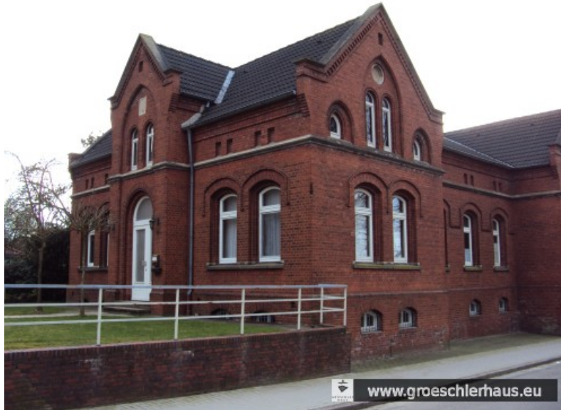
Dieses Gebäude an der Schulstraße hinter dem Amtsgericht Varel diente bis 1940 als Polizeigefängnis. Die Zellen befanden sich im Kellergeschoss (Aufnahme: Frerichs, 2012).
